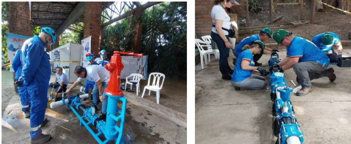
Figura 7. Montaje prueba red de acueducto Olimpiadas Sanitarias Colombia 2022
