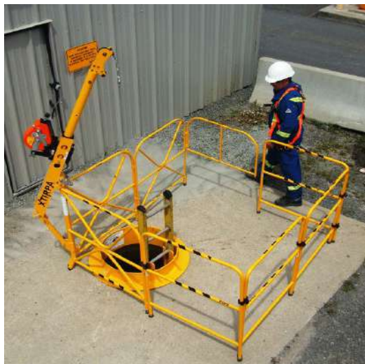
Figura 19. Prueba Espacios Confinados
