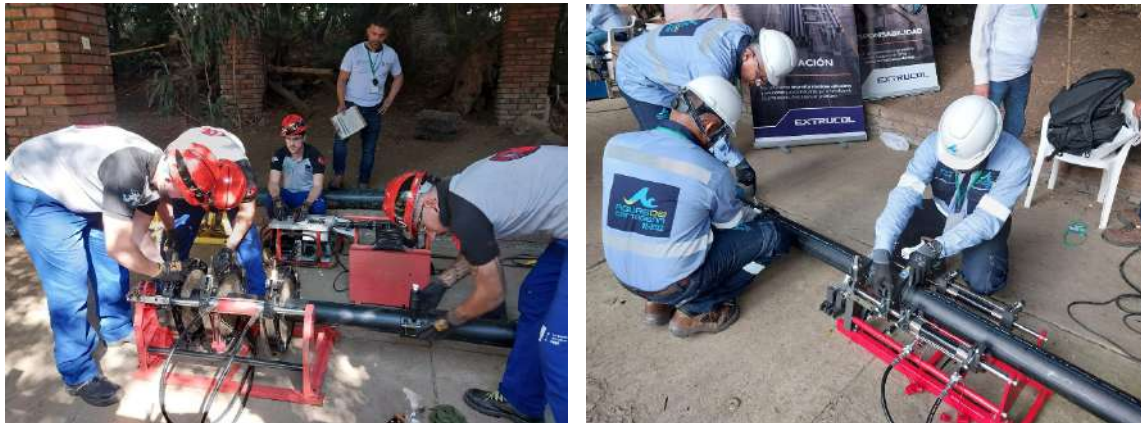
Figura 10. Montaje prueba de termo y electrofusión, Olimpiadas Sanitarias 2022
